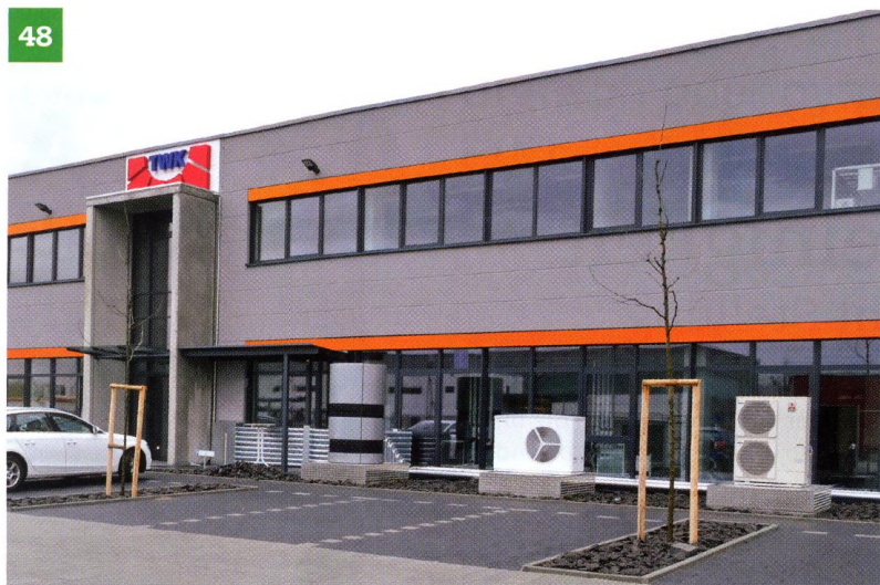
Ausgezeichnet: Neubau der TWK Karlsruhe
