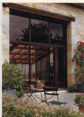
Přestavba stodoly začíná rekonstrukcí vjezdových vrat. 41
