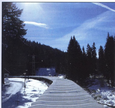
Malá vodní elektrárna Čerňkova pila (Zdroj: ČEZ, a.s.)
