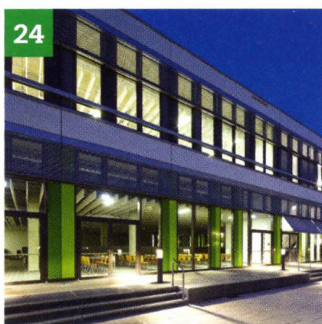
Kältetechnik für die Mensa
