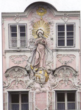
Detail průčelí lékárny v Obernbergu v Horních Rakousích
