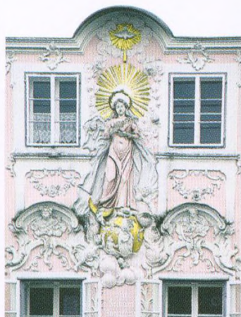
Detail průčelí lékárny v Oberbergu v Horních Rakousích
