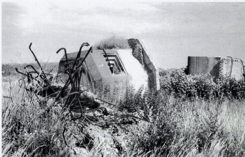
Obr. č. 1: Konec objektů „Podkrušnohorské linie“ v prostoru velkolomu Merkur u Pruněřova.
