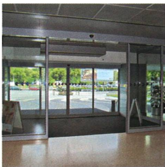
Automatické posuvné dveře zaručují bezbariérový, bezkontaktní vstup do objektu
