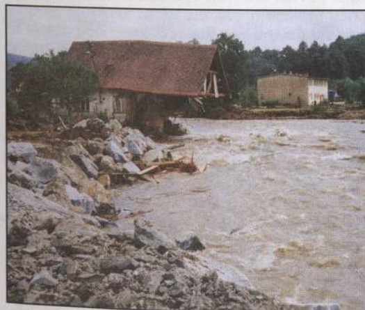
Bělá v Mikulovicích – následky povodně 1997
